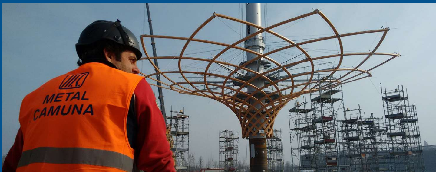
Una fase di costruzione dell'Albero della Vita per l'Expo Milano 2015
