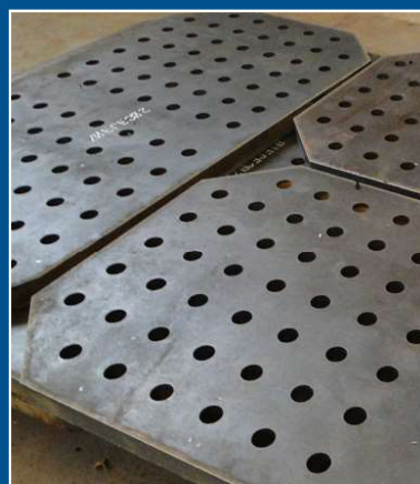
Giunti in lamiera forati a trapano e marcatura
